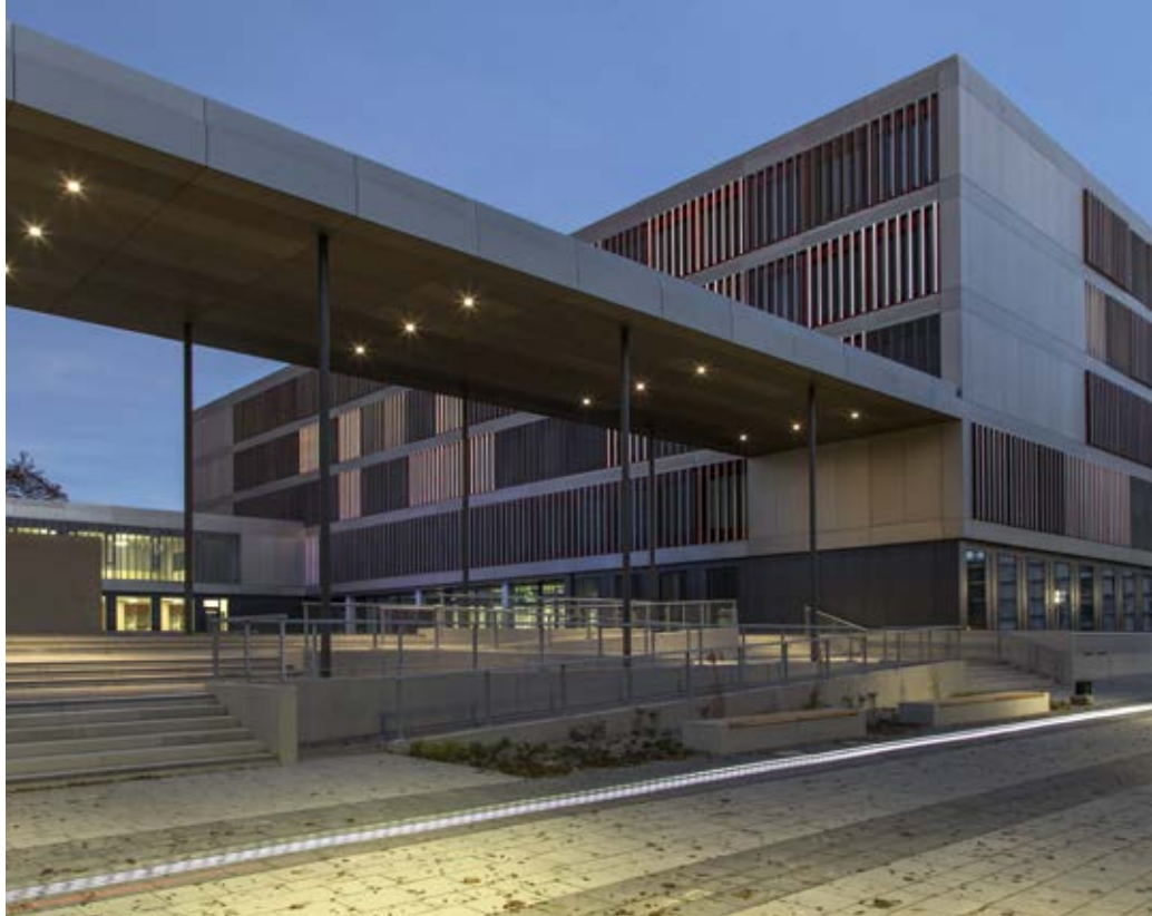
Die neue FOS/BOS in der Südlichen Ingolstädter Straße (Foto: MCA 2014)
